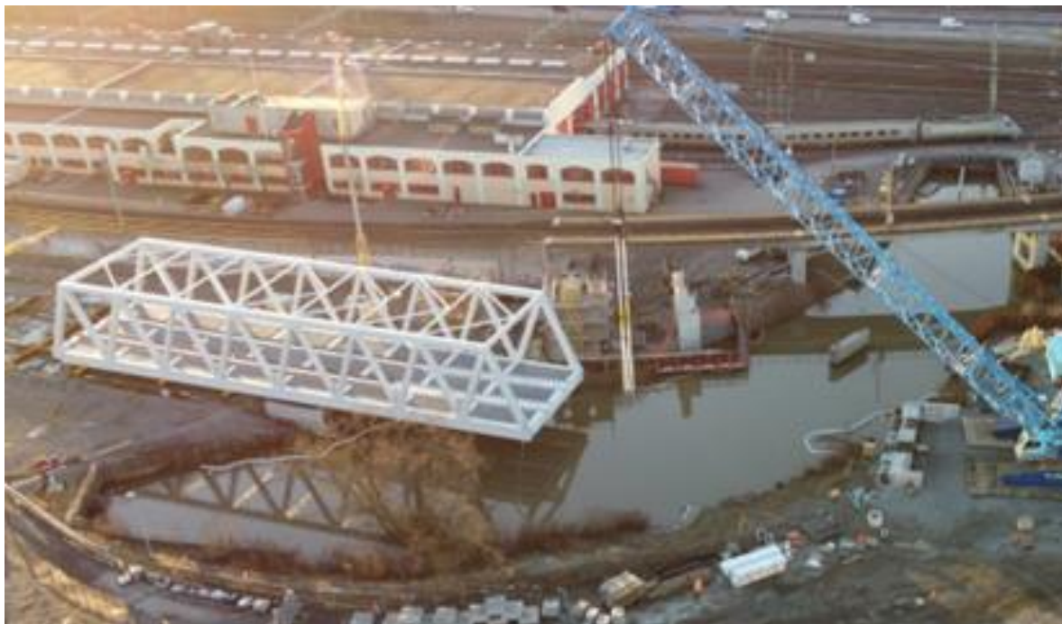
Figur 17. Anläggningsprojekt – bro i samband med montering på plats vid Olskroken Göteborg
